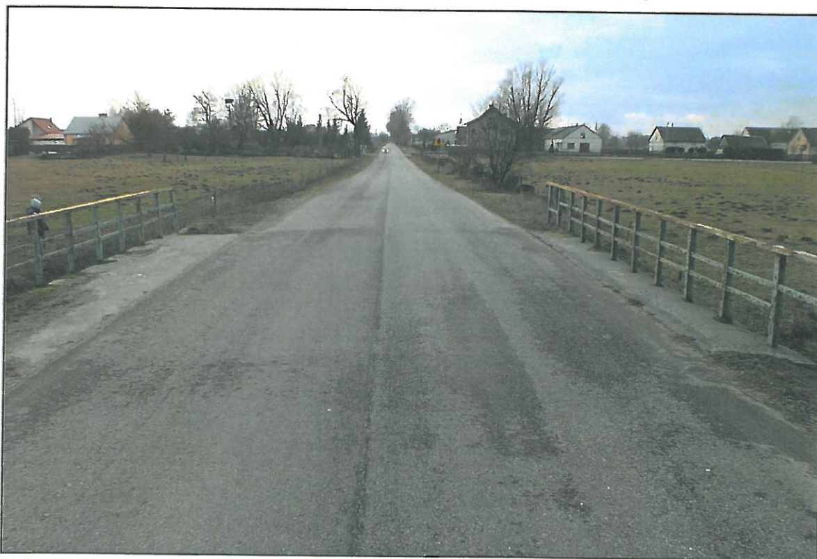
Rys. 2.2 Widok na obiekt od strony Myszała
