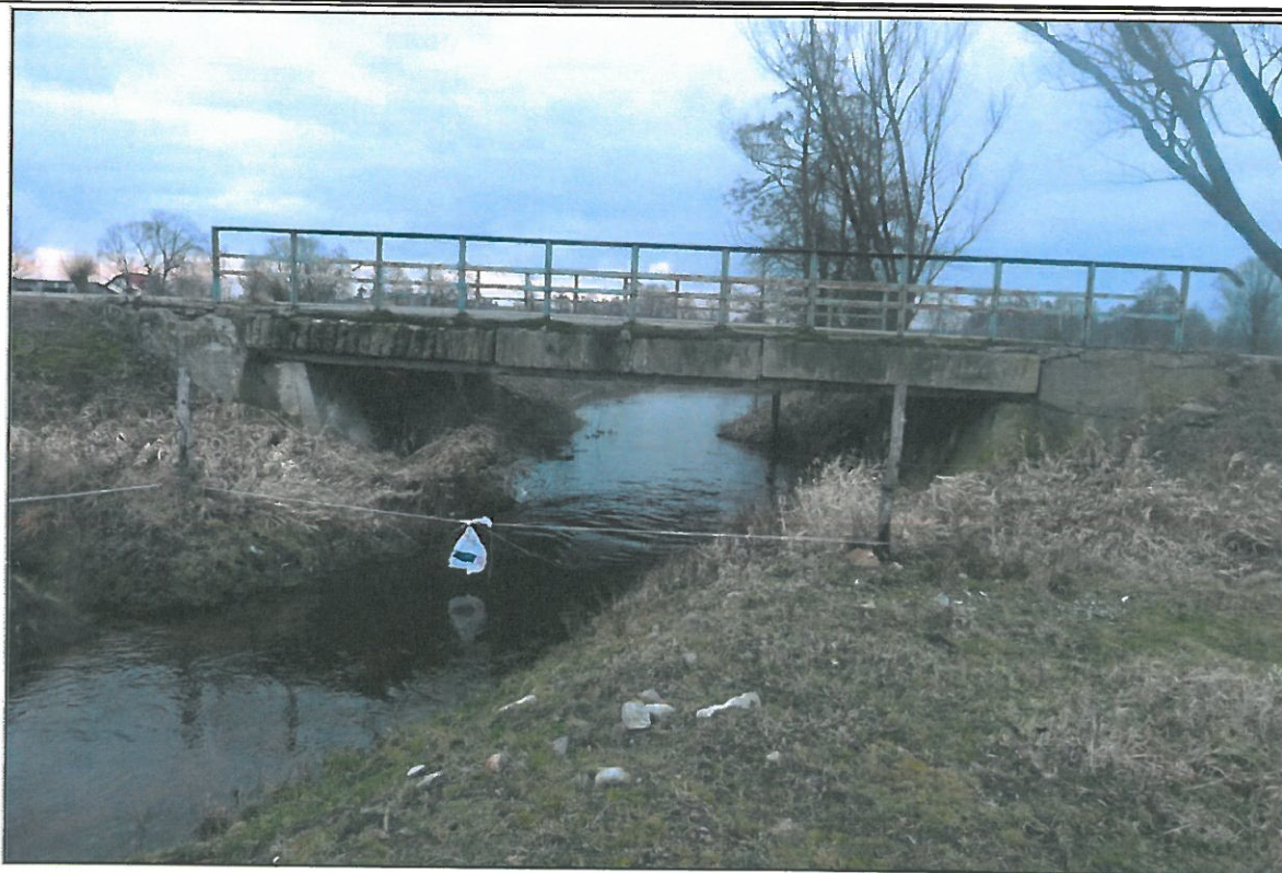
Rys. 2.1 Widok na obiekt od strony wody górnej
